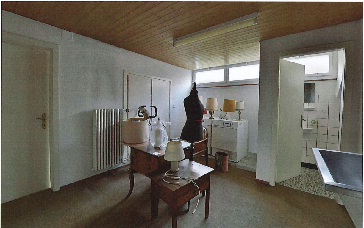
Staldernstrasse 13 | Ansicht des Dachgeschosses | vestigia 25.01.2024
