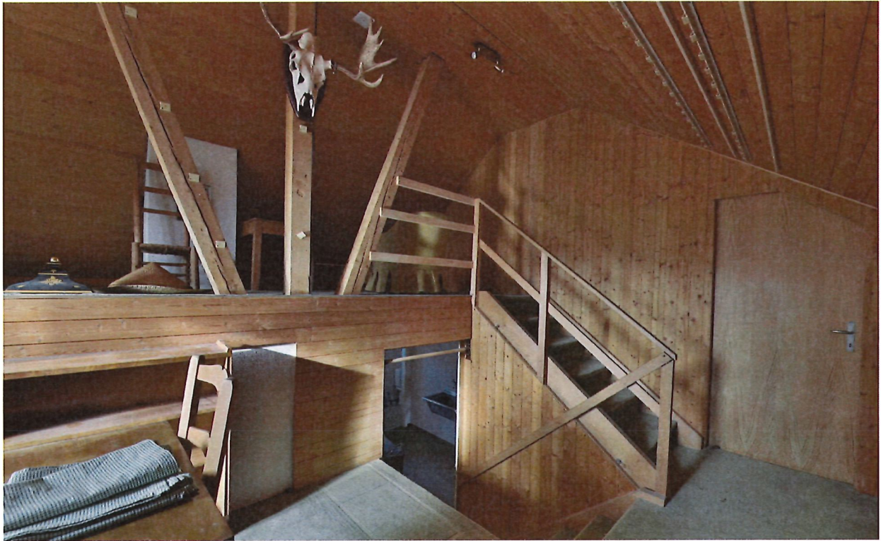
Staldernstrasse 13 | Ansicht des Dachgeschosses | vestigia 25.01.2024
