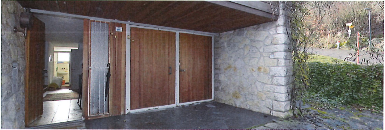
Staldernstrasse 13 | Ansicht des Hauseingangs mit Garage | vestigia 25.01.2024
