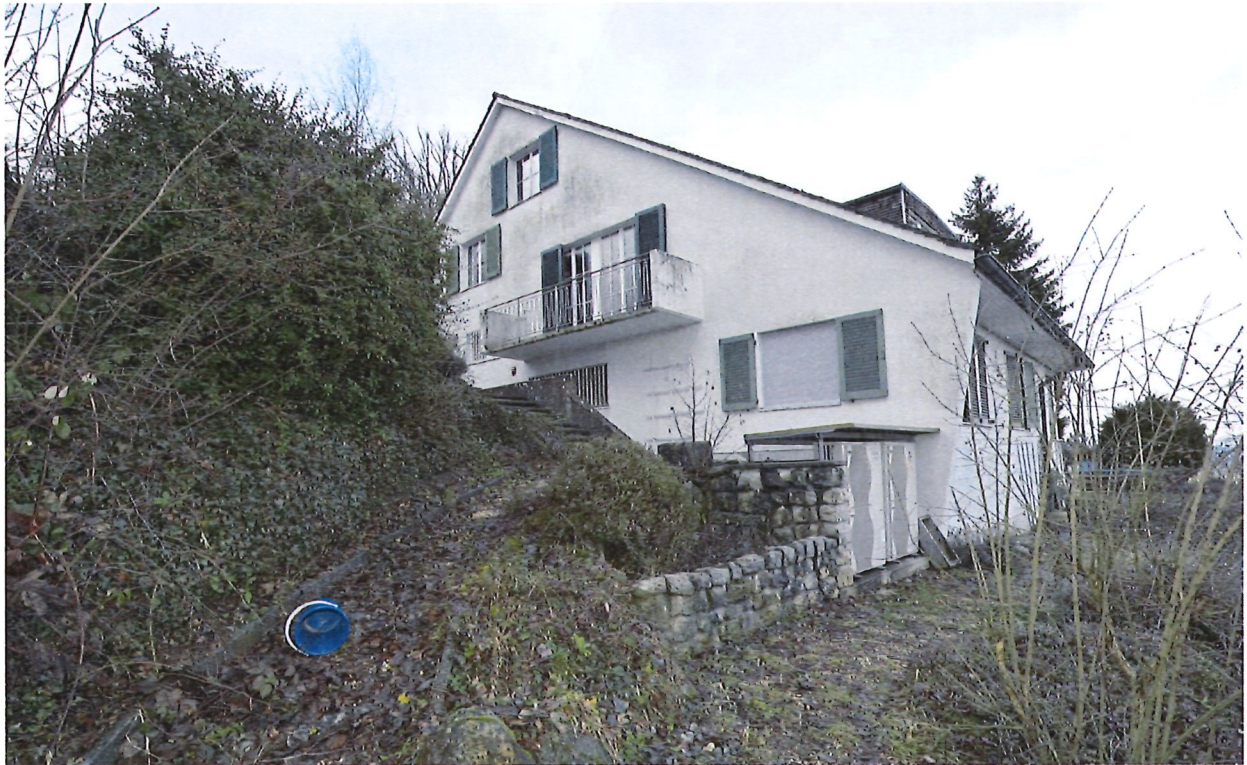
Staldernstrasse 13 | Ansicht von Südwesten | vestigia 25.01.2024
