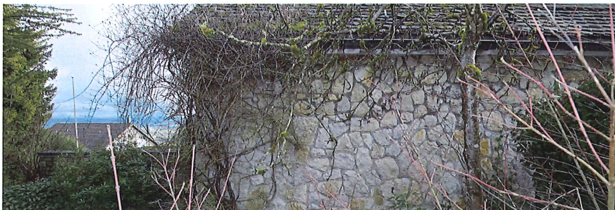
Staldernstrasse 13 | Ansicht der strassenseitigen Aussenmauer | vestigia 25.01.2024
